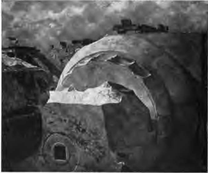
Fig. 24. — Chapiteau d'une colonne du Parthénon. Échine à profil d'égale résistance.
